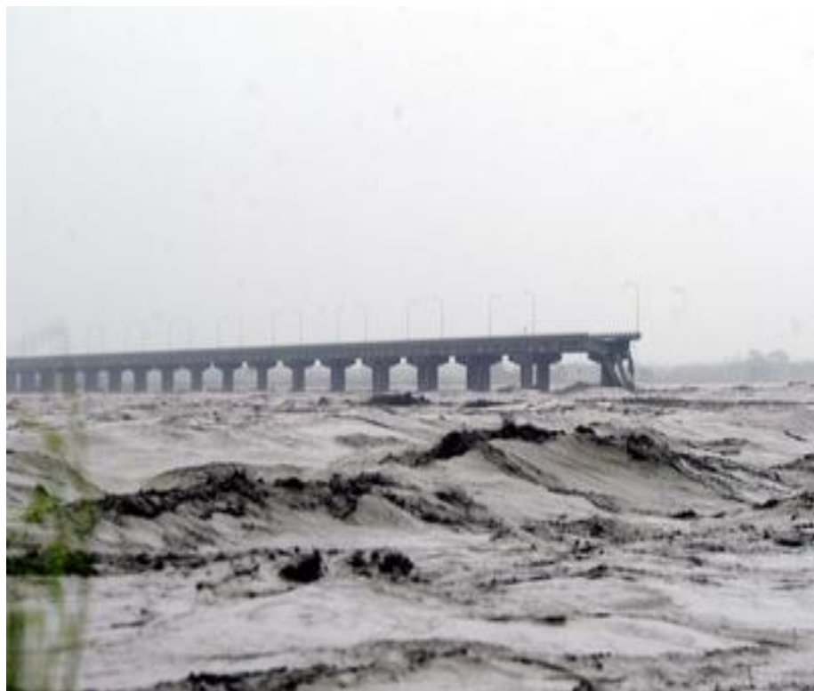
連絡高雄縣林園鄉和屏東縣新園鄉的 雙園大橋斷裂465公尺。
